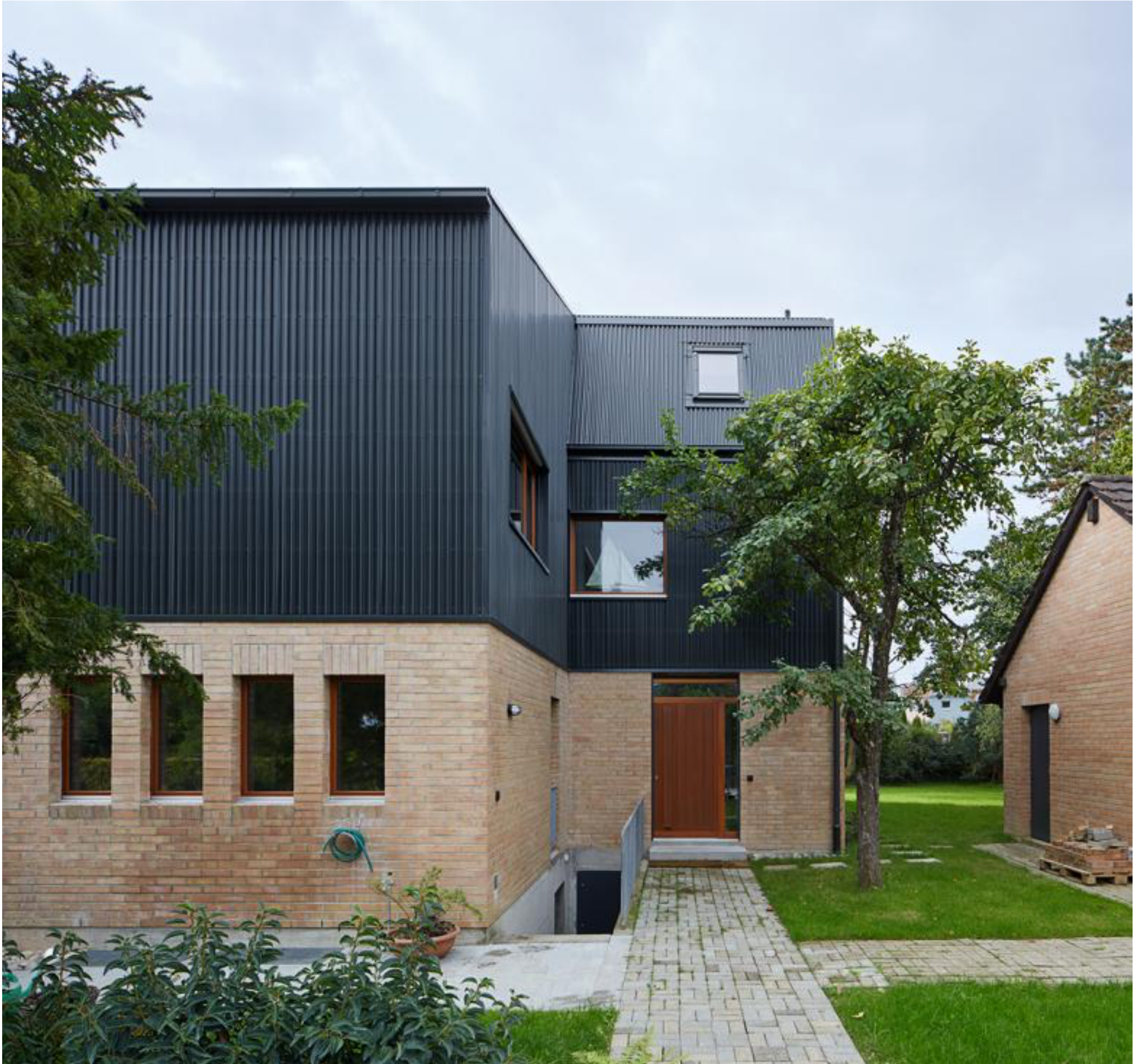
Strassenseitige Fassade Umbau. Bild: Tom Bisig
