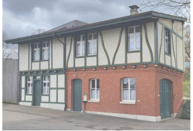
Sanierung Remise Riehen BS, 2025 - 2027
