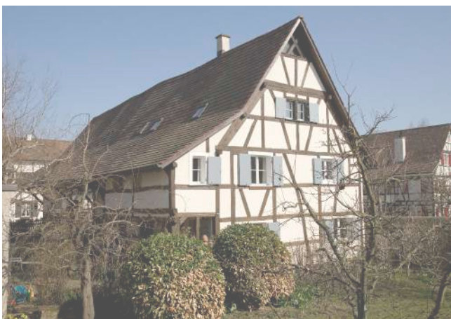
Sanierung Fachwerkhaus Allschwil BL, 2011
