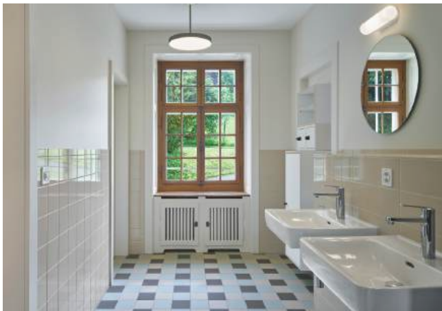
Sanierung Nasszellen Preiswerkhaus Riehen BS,
